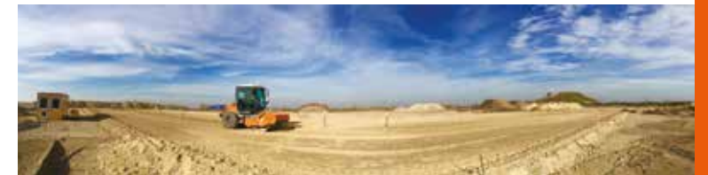
Abb. 6: Erprobung des FDVK-Systems für Oszillationswalzen unter Baustellenbedingungen mit einem HAMM H7i VIO Walzenzug
